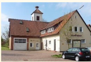
1. Schützenplatz (Altes Feuerwehrhaus)
