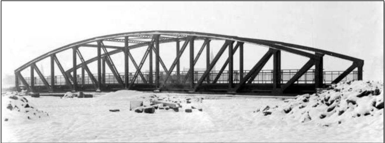
*Abb.: Bau der Brücke Nordsehl nach Pollhagen, 1912, Nr. 161, km 123,8 Erst werden die Brücken gebaut, dann das Bett ausgehoben<sup>9</sup>*
