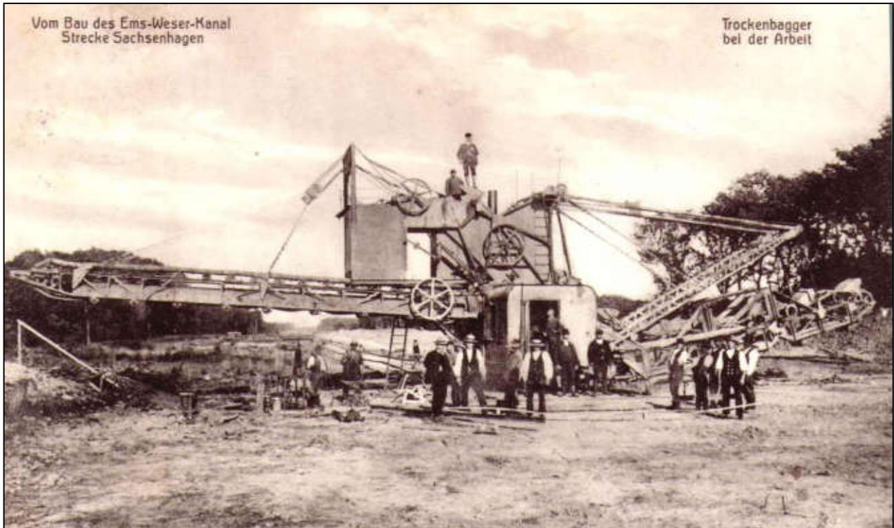
*Abb.: Dampfmaschinen betriebene Bagger unterstützen die Aushubarbeiten*
