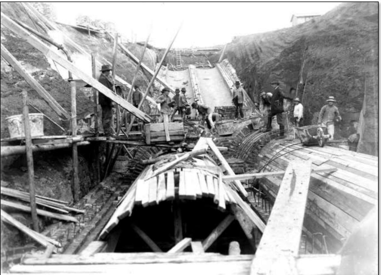
Abb: Düker Nr. 148 (alt), der so genannte "Holpe-Düker". Die nach Norden fließende Holpe quert hier den Kanal mit 2 Rohren. Blick auf die Schalung der Rohre (Vordergrund), in Bildmitte erkennt man die Bewehrung, im Hintergrund das aufsteigende betonierte Teilstück
