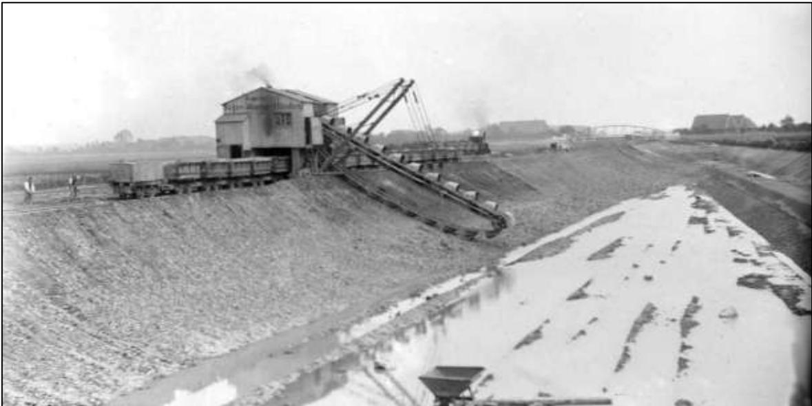
*Abb.: Blick auf Arbeiten am Kanalbett bzw. der wasserseitigen Böschung mittels Trockenbagger. Im Hintergrund die Straßenbrücke Pollhagen über den MLK (bei km 123,806, Brücke Nr. 161, alt)*
